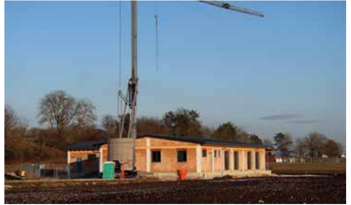
Die Jahreshauptversammlung bot Vereinsvorstand Sebastian Crusius die Gelegenheit über den Baufortschritt des Projekts zu berichten. Zudem informierte er, welche Arbeiten für 2024 vorgesehen sind.
